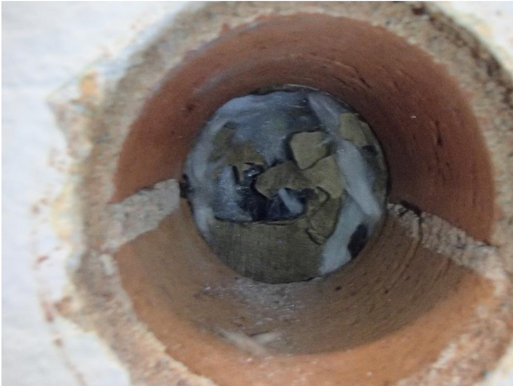
Kuva 5. Rakenneavaus RAKS2 vanhan musiikkiluokan ulkovaipparakenteeseen maanvastaisella seinällä.
