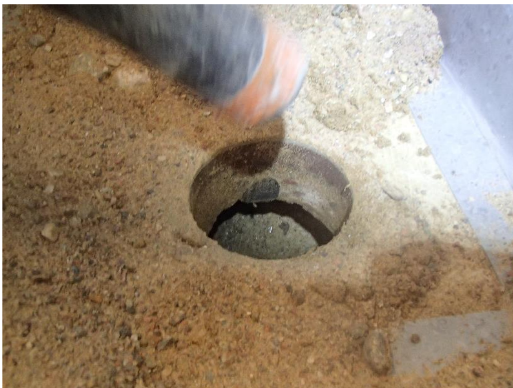
Kuva 10. Rakenneavaus, RAKL3, vanhan musiikkiluokan alapohjarakenteeseen.
