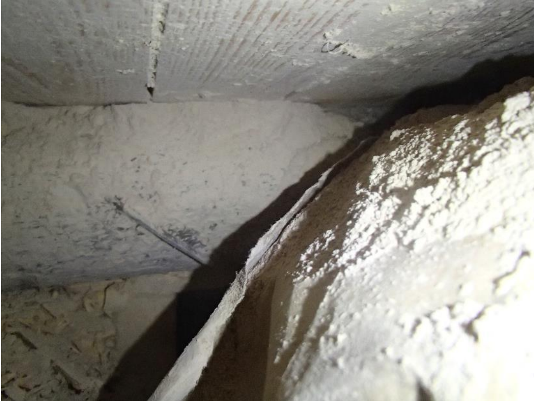
Kuva 7. Rakenneavaus, RAKL2, terveydenhoitajan huoneen välipohjarakenteeseen. Kuvassa lankkulattian alapuoli ja kantavat rakenteet.
