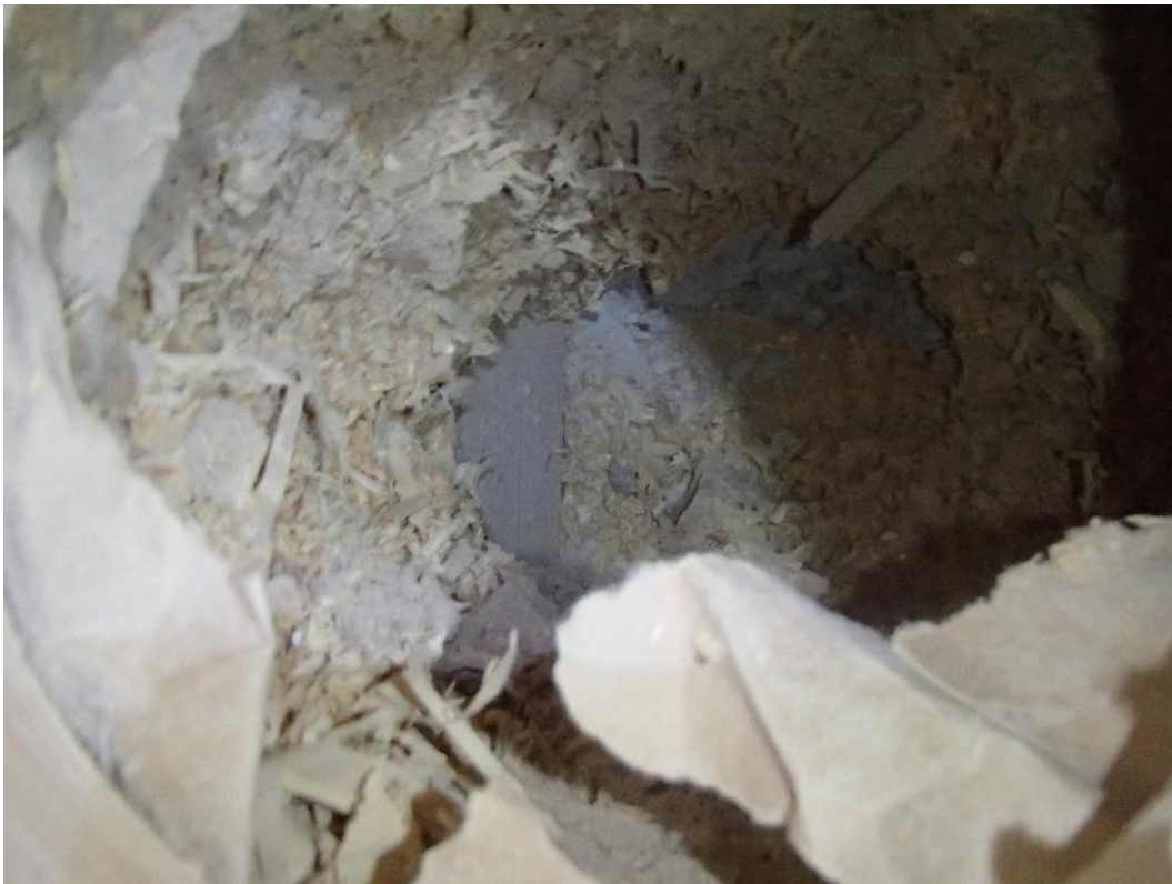
Kuva 6. Rakenneavaus, RAKL1, terveydenhoitajan huoneen välipohjarakenteeseen yläkautta kuvattuna.
