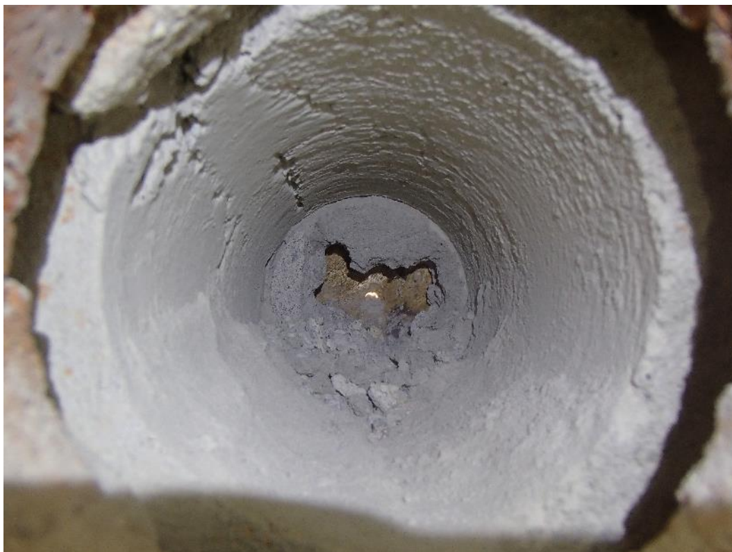
Kuva 3. Rakenneavaus RAKS3 terveydenhoitajan huoneen ulkoseinärakenteeseen.
