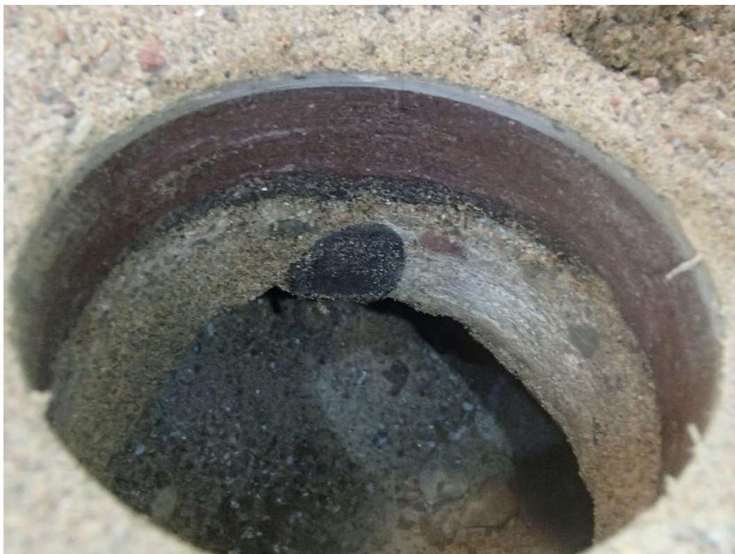
Kuva 11. Rakenneavaus, RAKL3, vanhan musiikkiluokan alapohjarakenteeseen.
