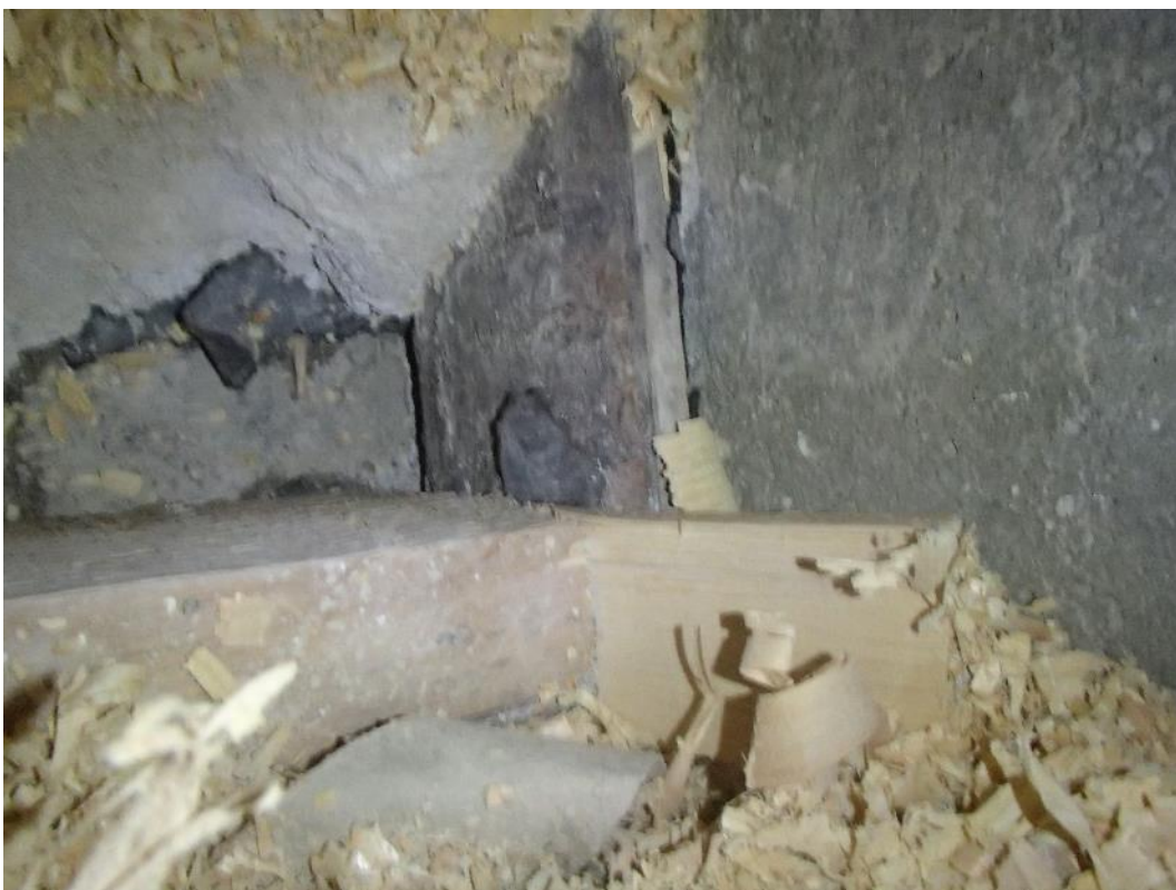
Kuva 9. Rakenneavaus, RAKL2, ruokalan välipohjarakenteeseen yläkautta kuvattuna. Lattian koolaukset on kiilattu betonipalkkeja vasten.
